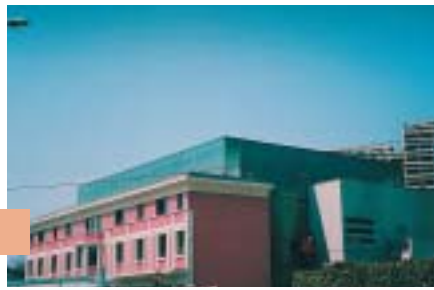
Maison des Activités "l'Arande": 865 000 € (fin de l'opération)
